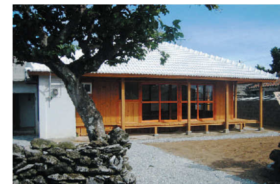
自分達で改修した1棟目
