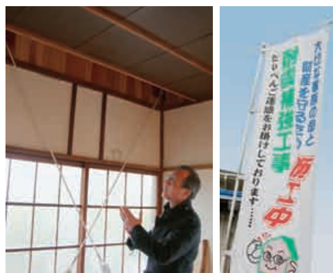
↑地域住環境研究所長の福井義幸さんが開発した独自の「耐震後付プレース工法」は重要なノウハウの一つ
