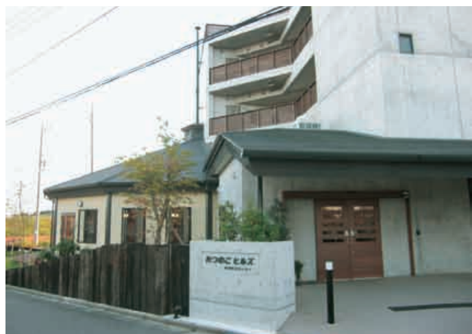
↑完成した「シニア村」=分譲マンション「たつのこヒルズ」外観
