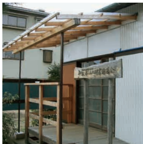
↑協議会事務所外観
